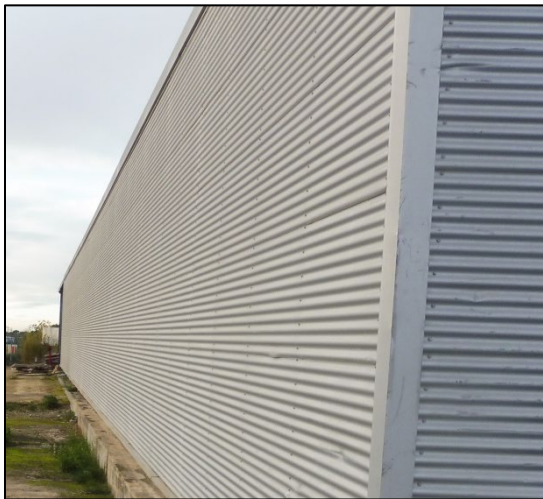
Figure 14. Mur est en bardage métallique
